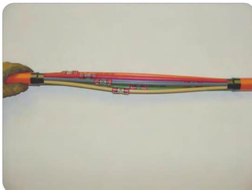
Рисунок 58 – Пример размещения коннекторов в месте соединения пакетов микротрубок
