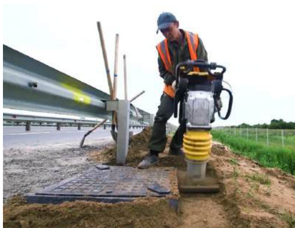
Рисунок 45 – Уплотнение грунта с применением вибротрамбовочного аппарата
