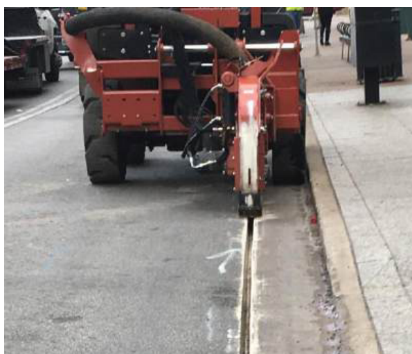
Рисунок 25 – Пример размещения микротраншеи в пределах проезжей части
